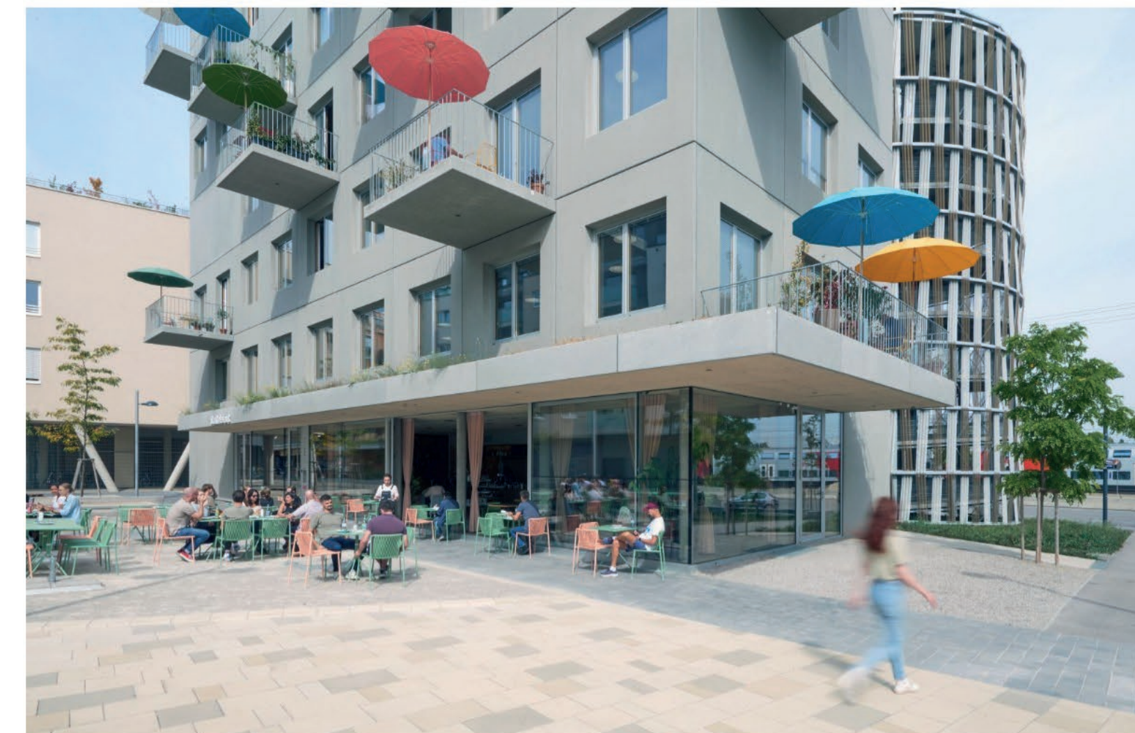
Die Fassade mit großen Fenstern im strengen Betonraster hebt sich von der Glaskasten-Monotonie typischer Büroebauten ab. (Foto: Andreas Buchberger)
