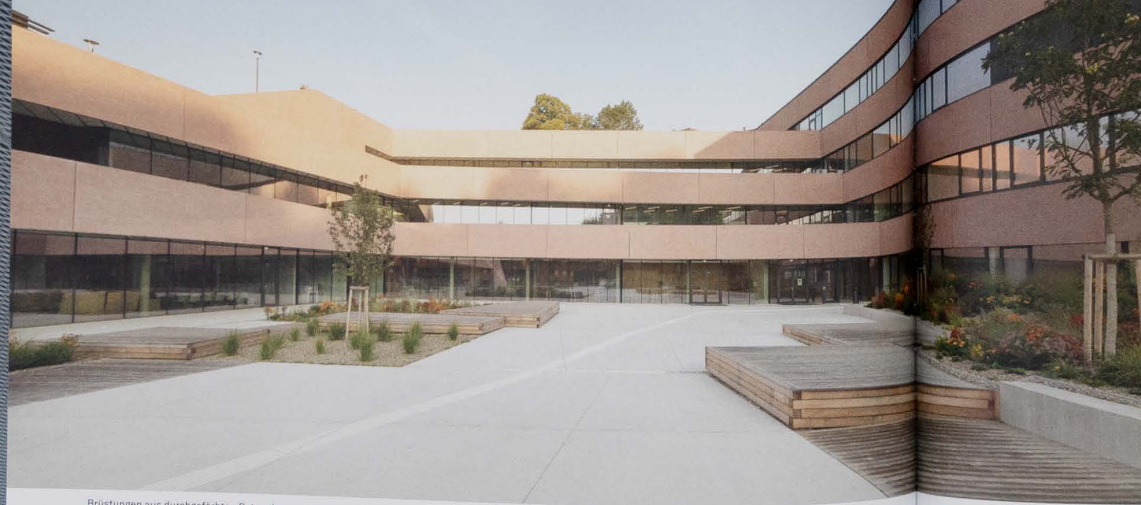
Brüstungen aus durchgefärbten Betonplatten schirmen die Arbeitsplätze des Mitteltraktes ab. The parapets are made from coloured concrete panels and unobtrusively screen those working behind the floor-to-ceiling windows.
