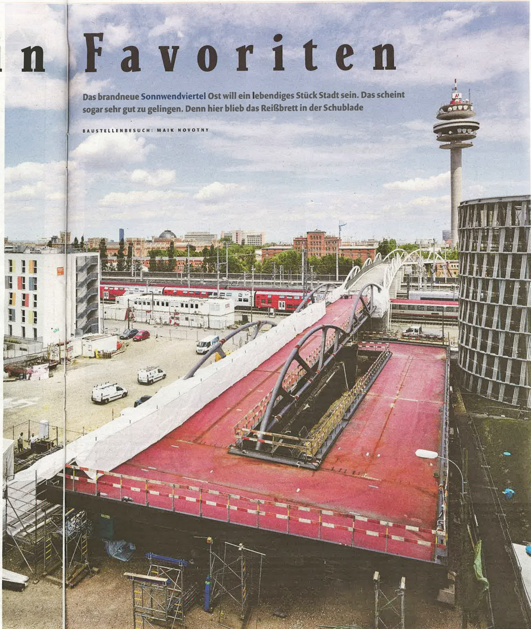
Brückenschlag: Der Fuß- und Radweg über die Bahnlinie verbindet das Arsenal im 3. Bezirk mit dem Sonnwendviertel im 10. Bezirk
