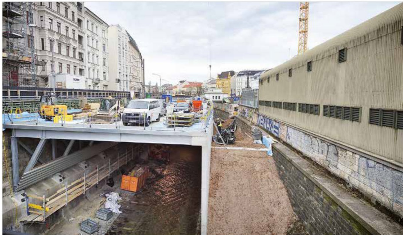
oben: Bauarbeiten für die U2 bei der Station Pilgramgasse
