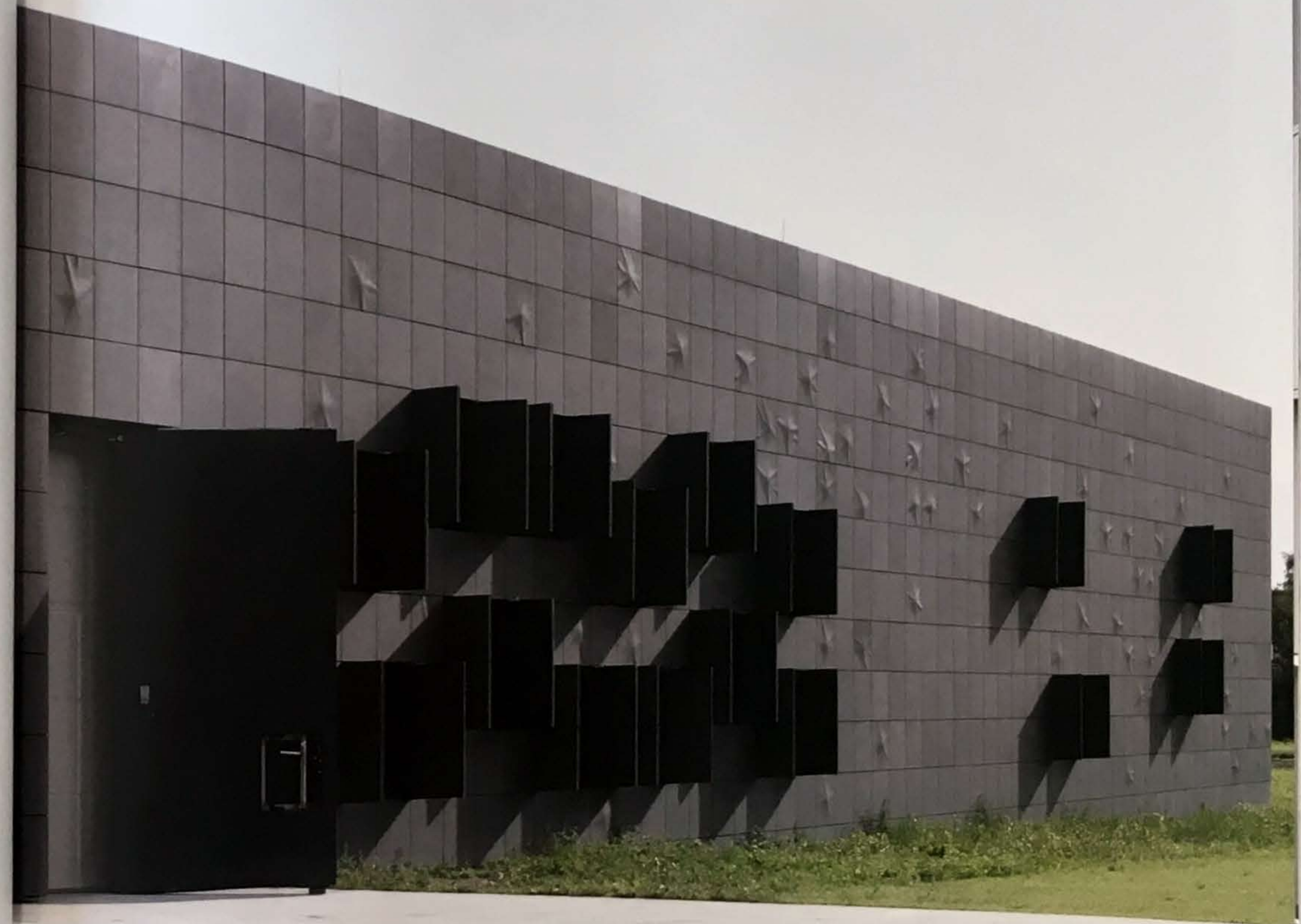
Abb. 5 (Bild oben) ... z. B. das Tor für Anlieferungen und die Fenster zur Tischlerei
