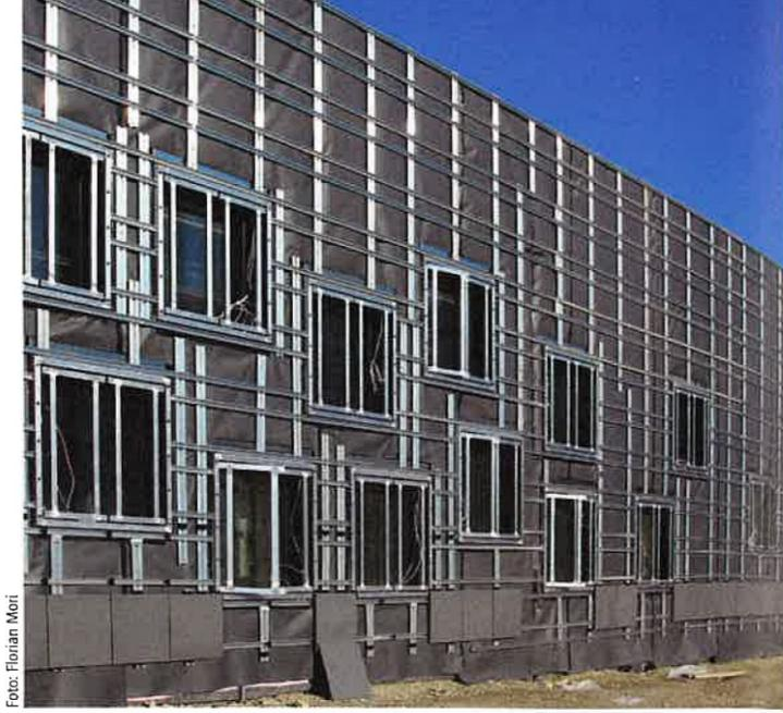
Die Anarbeitung der Unterkonstruktion und Sonderteile erfolgte im Werk. Auf der Baustelle wurden die Einzelteile schienenweise montiert.
