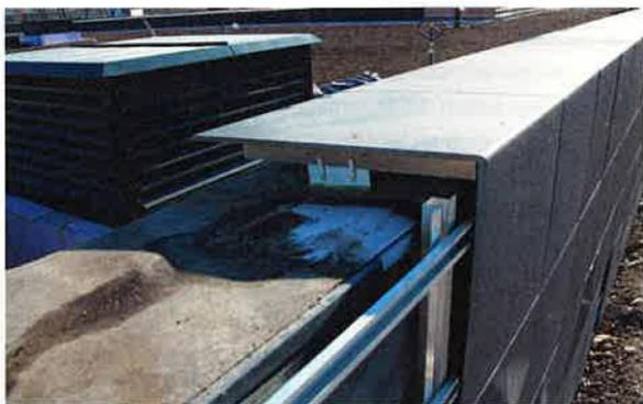
Die VHF aus Glasfaserbetonplatten wurde mittels Hinterschnitt-Befestigungstechnik unsichtbar auf einer Alu-Unterkonstruktion befestigt.
