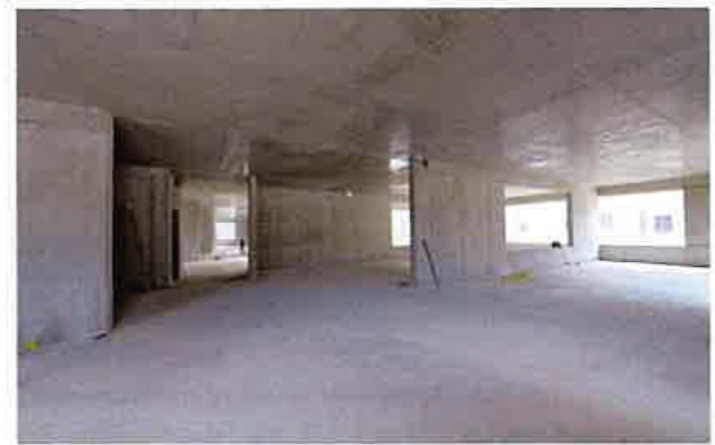
1, 2 Baustelle Werkstattengebäude Fotos Rudi Palme
