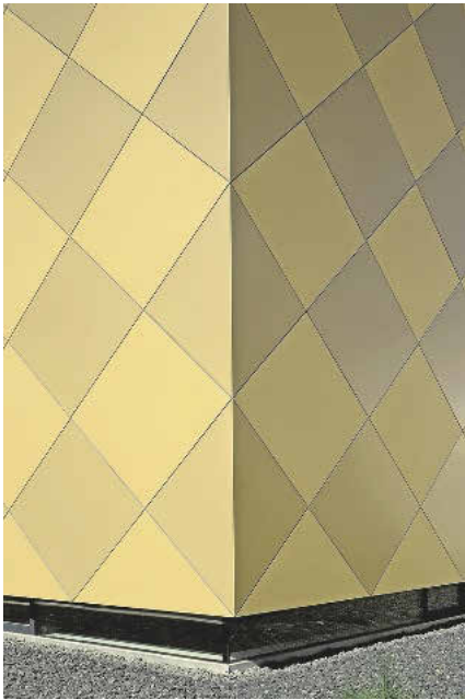
Alle vier Ecken sind an der Diagonale gekantet und die Metallhülle scheint um das Gebäude gefaltet zu sein.
