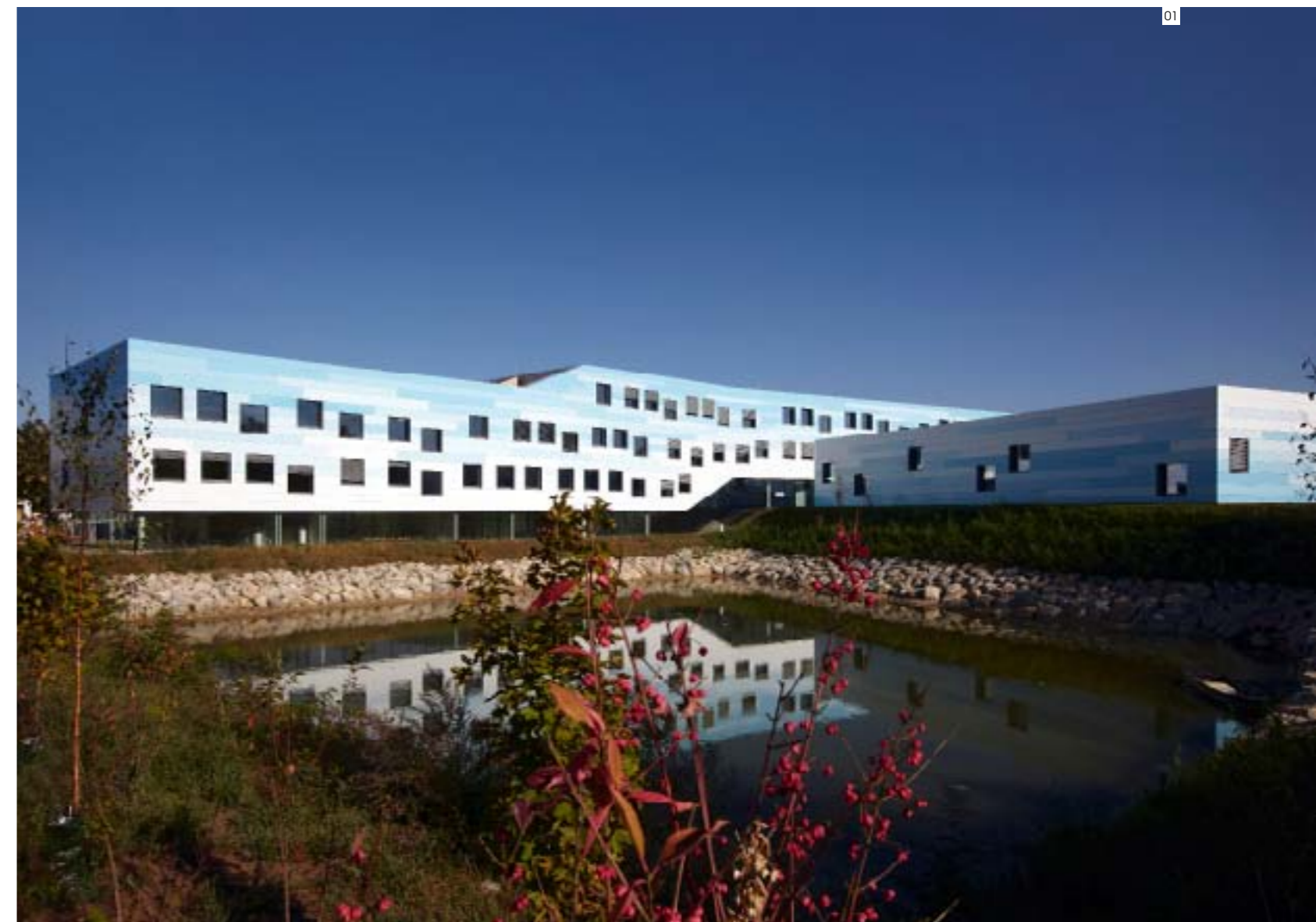
01 围绕池塘的教学楼和体育馆
